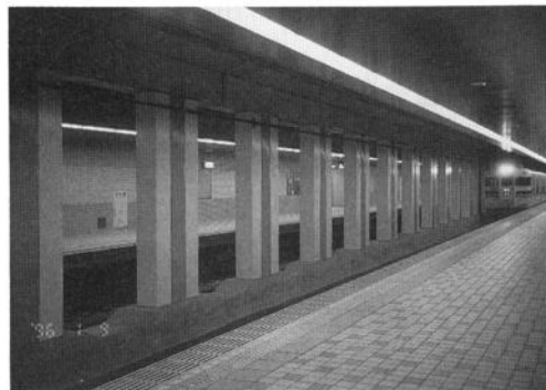
写真-V.8.2 大開駅の復旧状況
