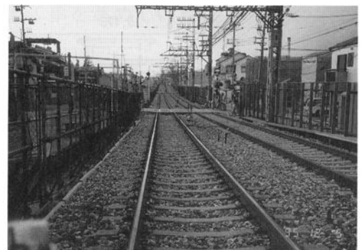
写真-V. 10.5 復旧工事の完成
