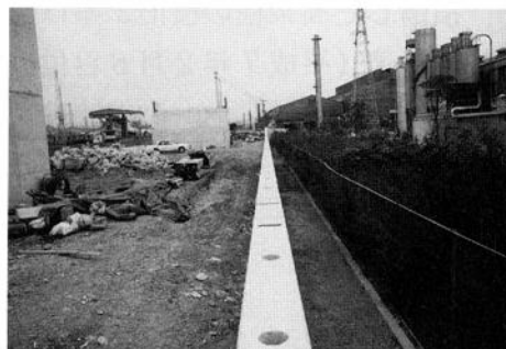
写真-V. 10.1 復旧工事の完成
