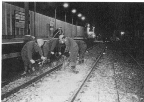
写真-V. 10.4 復旧工事中の状況 (西宮市森具西踏切)
