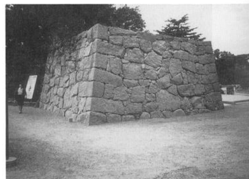
写真-V. 11. 6 復旧工事の完了
