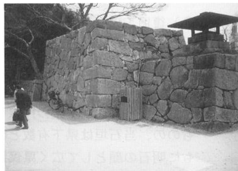
写真-V. 11. 4 復旧工事の完了
