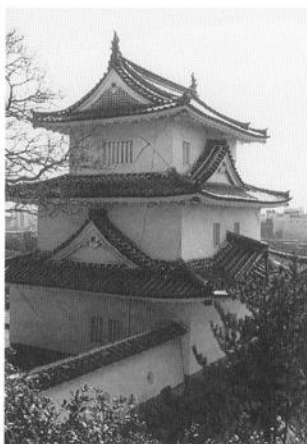
写真-V. 11. 7 曳屋前の坤櫓
