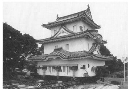
写真-V. 11. 8 曳屋工事中の坤櫓
