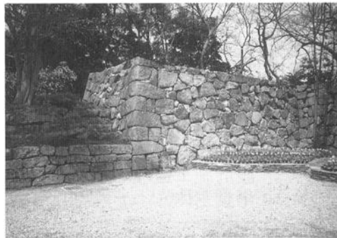
写真-V. 11. 2 復旧工事の完了
