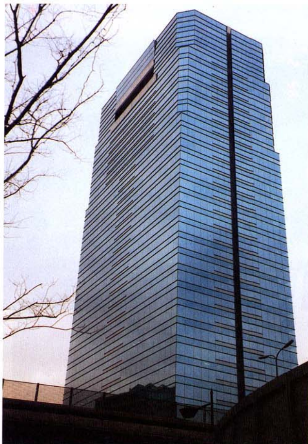
写真 2-2-2-7 ガラスの被害のない SSGカーテンウォール
