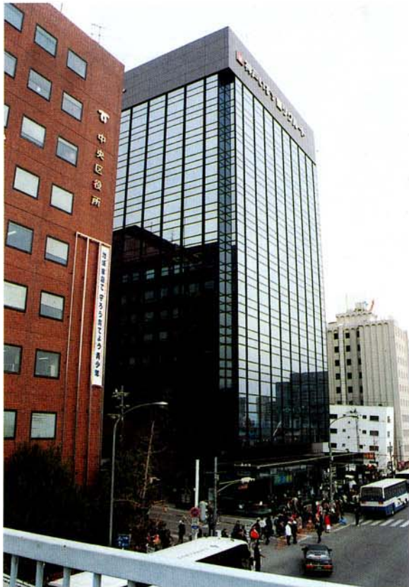
写真 2-2-2-3 ガラスの被害のない方立方式
