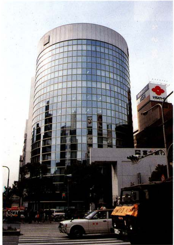
写真 2-2-2-4 ガラスの被害のない方立方式
