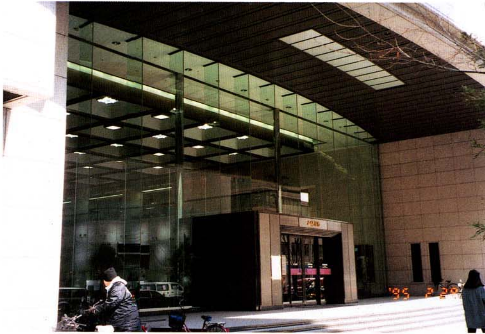
写真 2-2-3-4 三宮地区の破損なしの例
