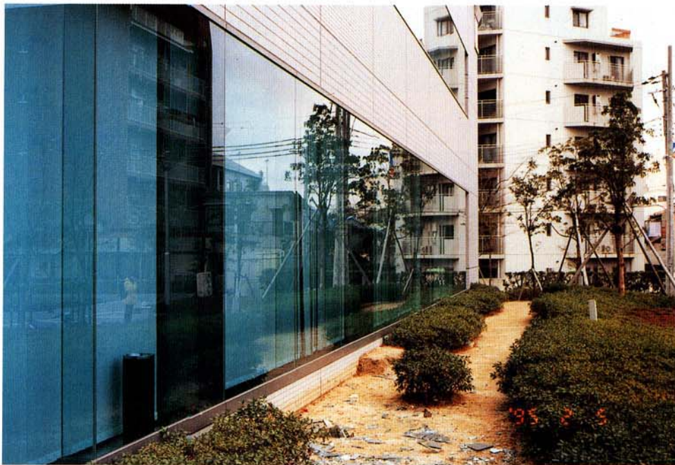
写真 2-2-3-5 芦屋市内の破損なしの例
