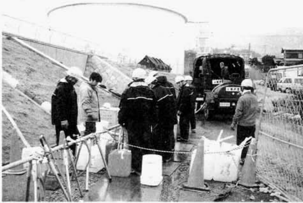
応急給水の模様 (拠点配水池)
