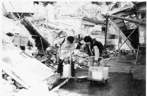
応急給水の模様 (仮設給水栓)
