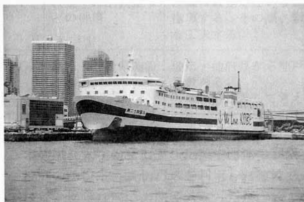
暫定復旧し、供用を再開したフェリーバース (六甲アイランド RF-1)
