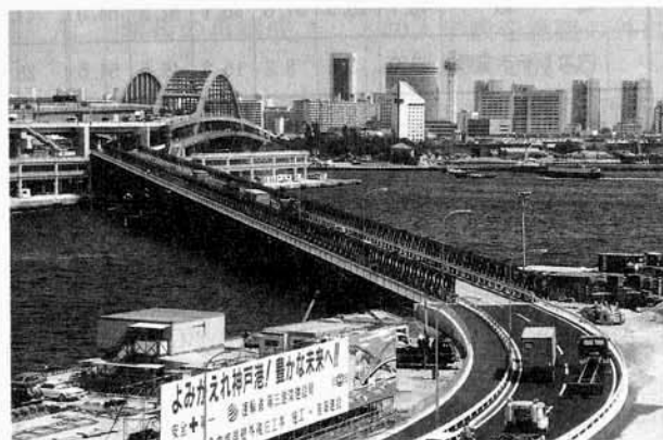
神戸大橋に設置した仮道路
