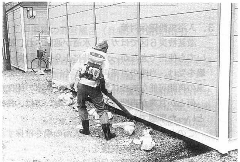
仮設住宅床下に薬剤散布（須磨区）
