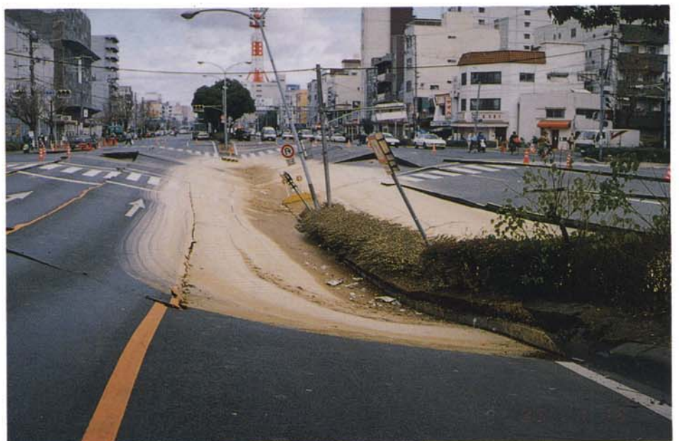
陥没した道路、道路下は高速大開駅 (1月19日、兵庫区水木通)
