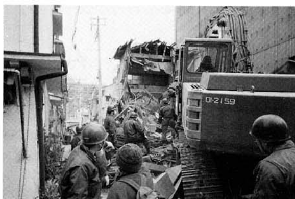
解体作業（雲井通3丁目）
